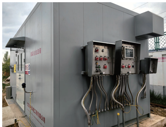
危废贮存库外部3
