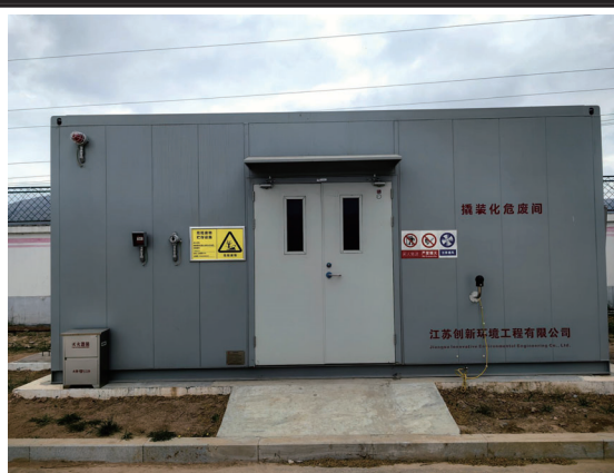
危废贮存库外部2
