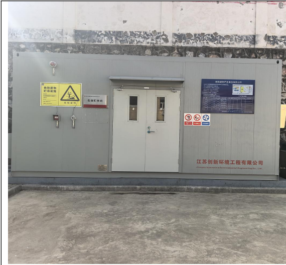
购买的标准化危废储存库
