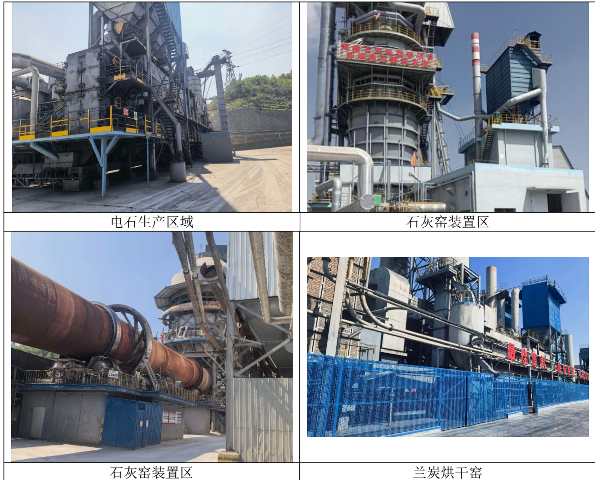
图 4.1-2 生产装置区现场图
