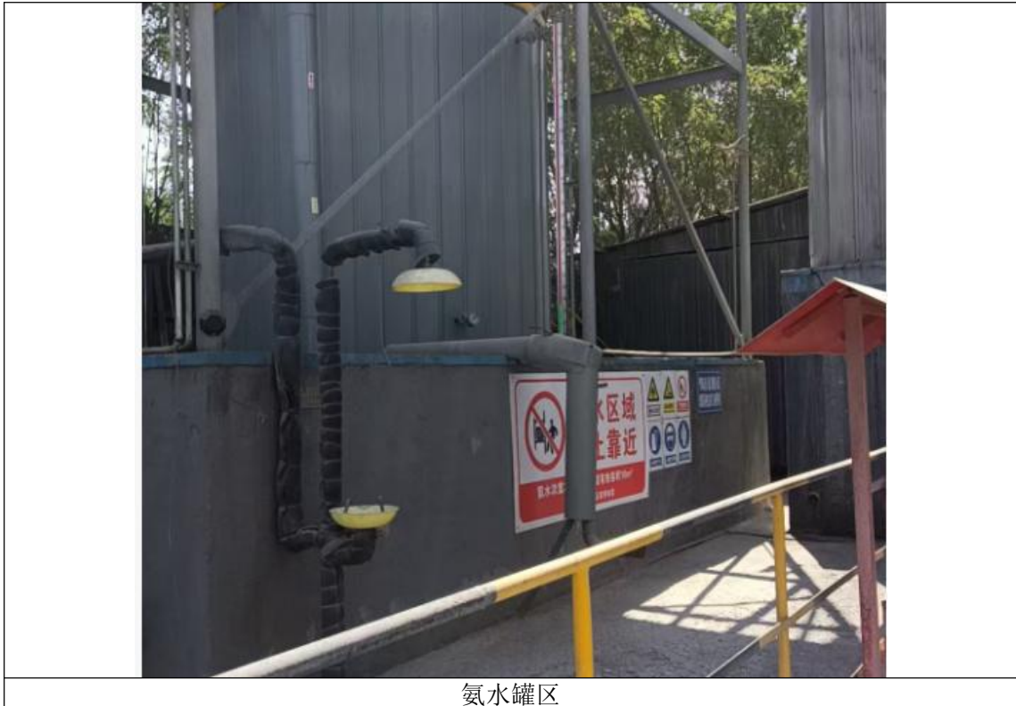
氨水罐区 图 4.1-3 储罐区照片
